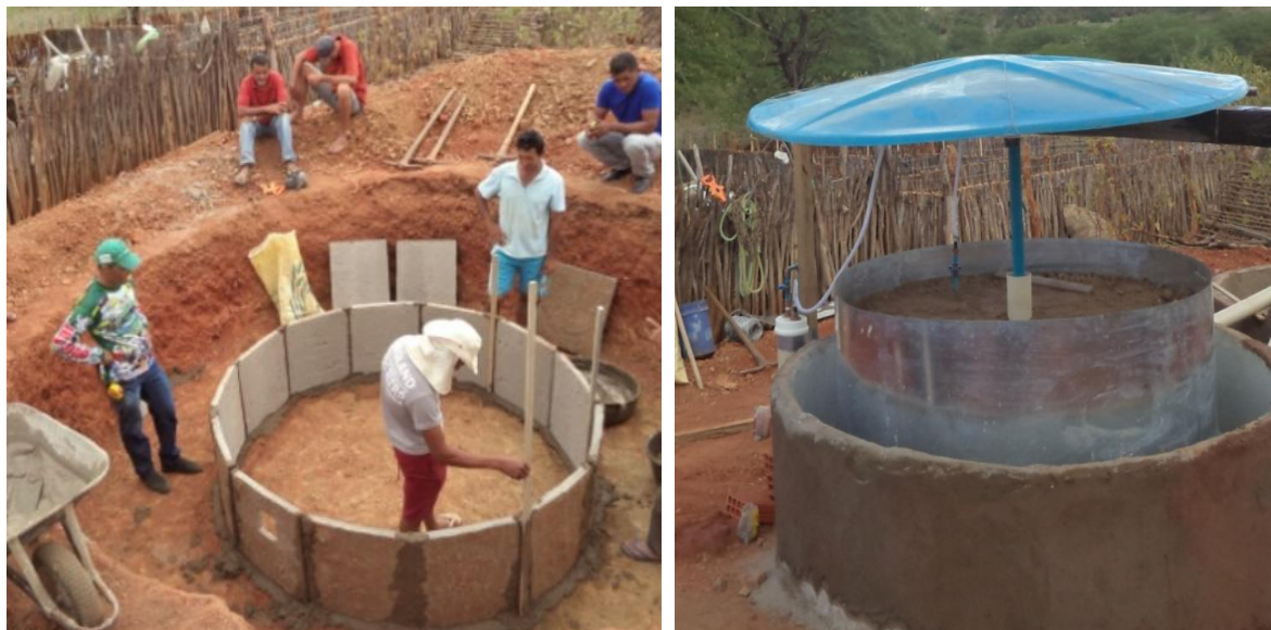
Figura 24: Construção de biodigestor com participação da comunidade.
